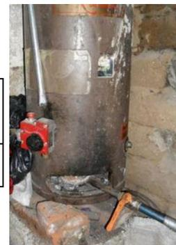
Figura 3. Calentador de Agua con quemador de biogás.
